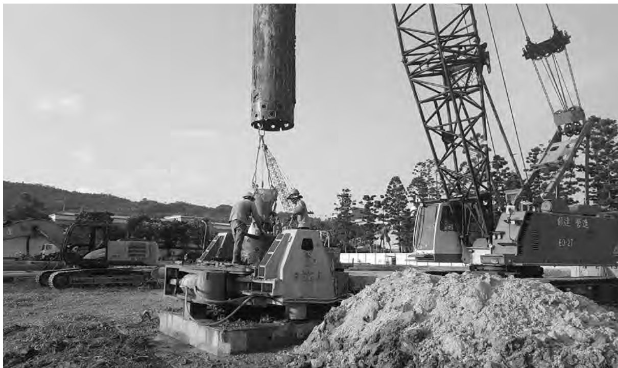
經國七海文化園區施工狀況
